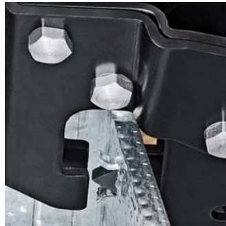
Das Stempelwerkzeug wird durch die Profilbleche gedrückt
